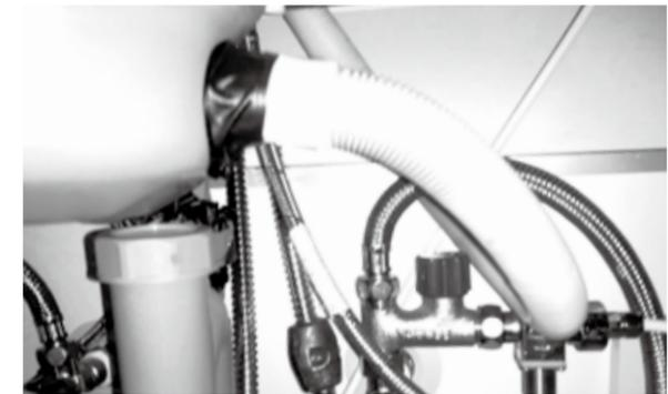
廚房洗槽下軟管常脫落，可以膠帶等更加牢固
