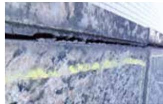
外牆石材矽利康填縫膠老化離異
